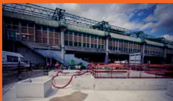
Le Puits Valmy, en voie de finalisation, aura une double fonction : à la fois accès pompiers et poste de ventilation et de désenfumage de la ligne 12. Fin des travaux prévue en 2016.
